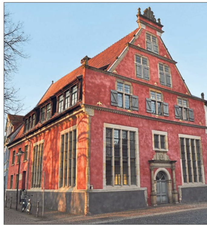
Das Fröhherrenhaus heute: 2004/2005 wurde das Gebäude grundlegend saniert. Fassade und Fenster erhielten dabei ihr ursprüngliches Aussehen zurück. Fotos (2): Jana Budek
