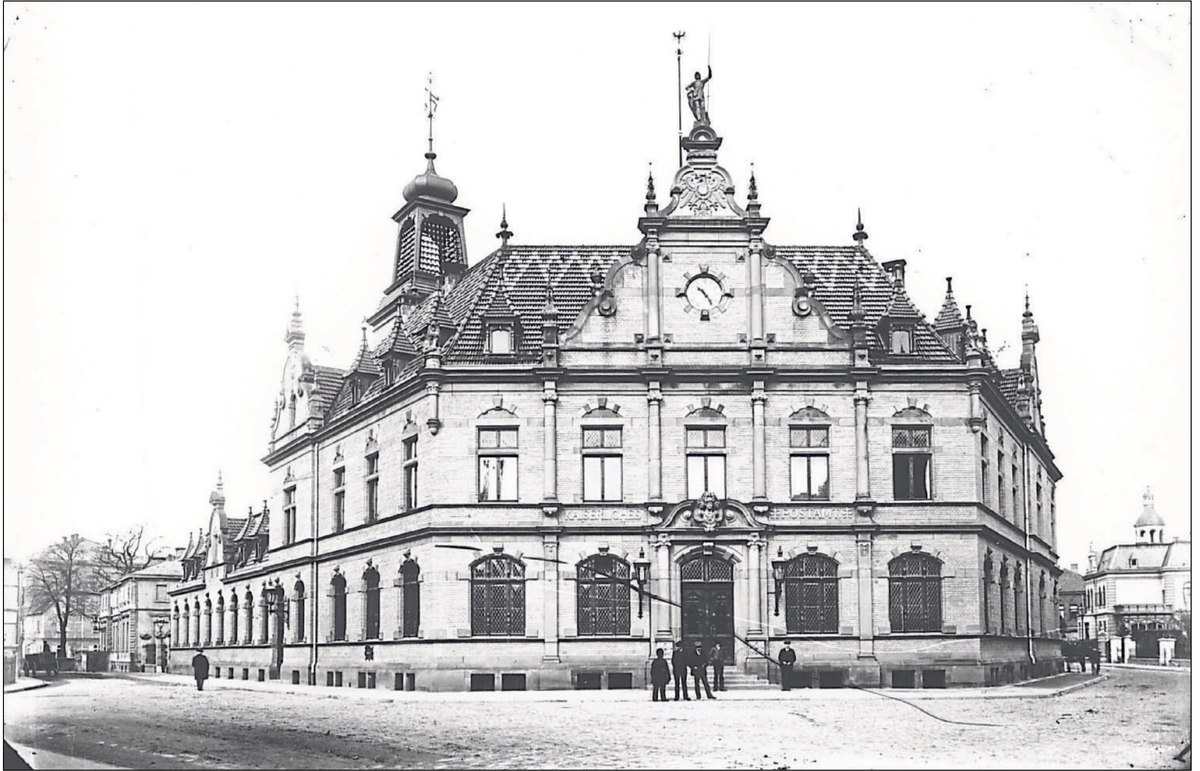
Das Kaiserliche Postamt etwa zehn Jahre nach seiner Einweihung: Heute fehlen der linke Seitenflügel und das sich anschließende Gebäude des Weinklubs. Sie wurden für den Bau des Fernmeldezentrens abgerissen.
