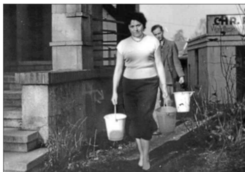
Elfriede Rahmüller schleppt zwei Wassereimer. Den eigenen Anschluss durfte die Familie vorübergehend nicht nutzen.
