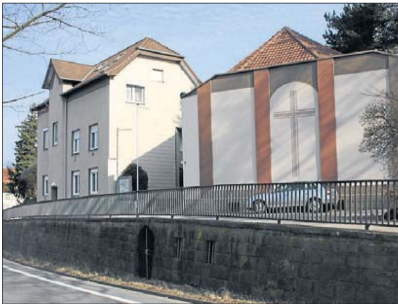
Die Gebäude an der Jahnstraße, die heute von der Landeskirchlichen Gemeinschaft Herford genutzt werden, gehen zurück auf die Brauerei Wefing. Links stand das Wohnhaus und rechts die Fabrik. Die Gebäude waren ursprünglich miteinander verbunden. Foto: Hartmut Horstmann
